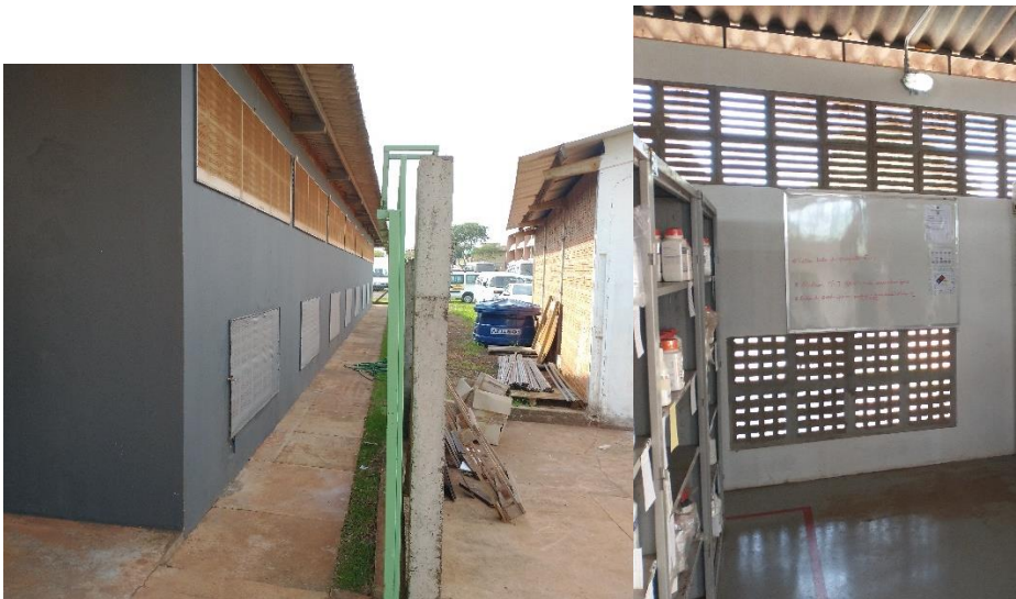
Figura 12 – Cobogós e tele protetora para facilitar ventilação natural
