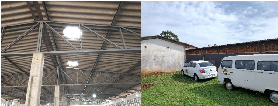
Figura 8 – Exaustores eólicos com ventilação automática
