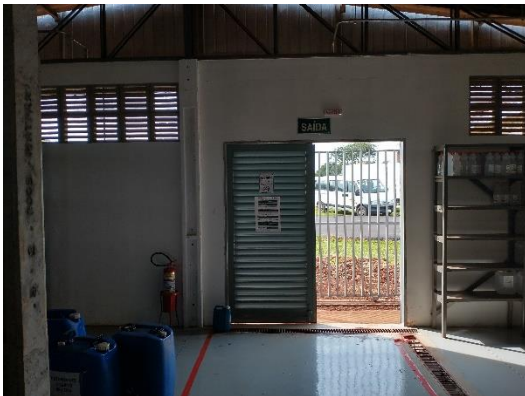
Figura 7 – Saída de emergência
