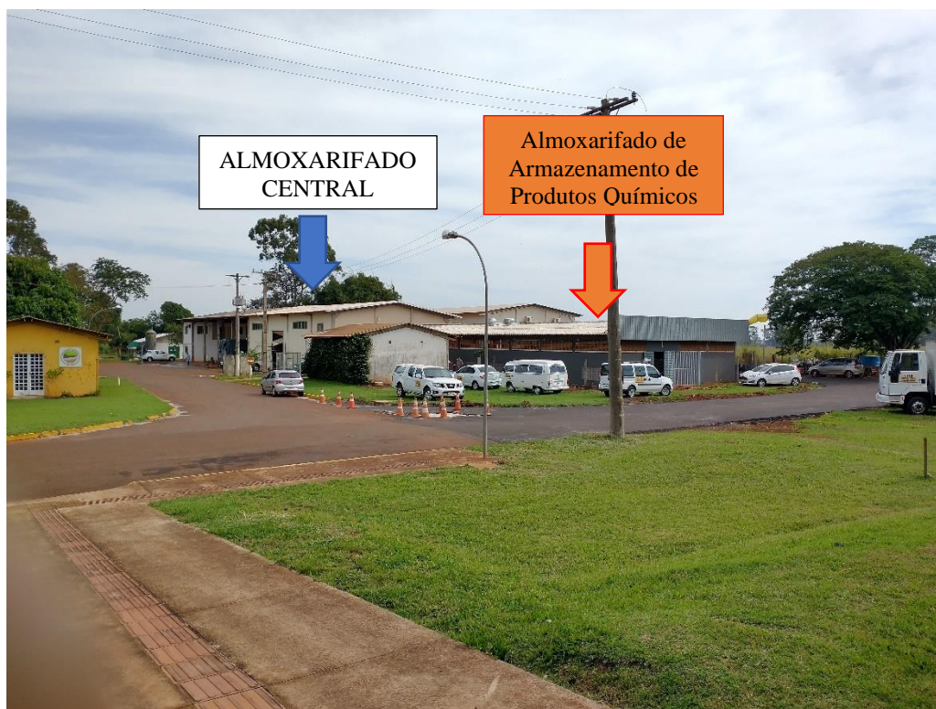
Figura 2 – Edificações próximas ao Almoarifado de Armazenamento de Produtos Químicos
